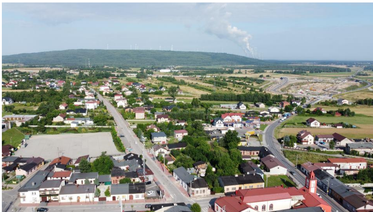
Fotografia 3. Widok na elektrownię wiatrową na Górze Kamieńsk
