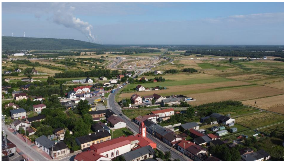
Fotografia 1. Budowa autostrady A1 - zjazd w Kamieńsku
