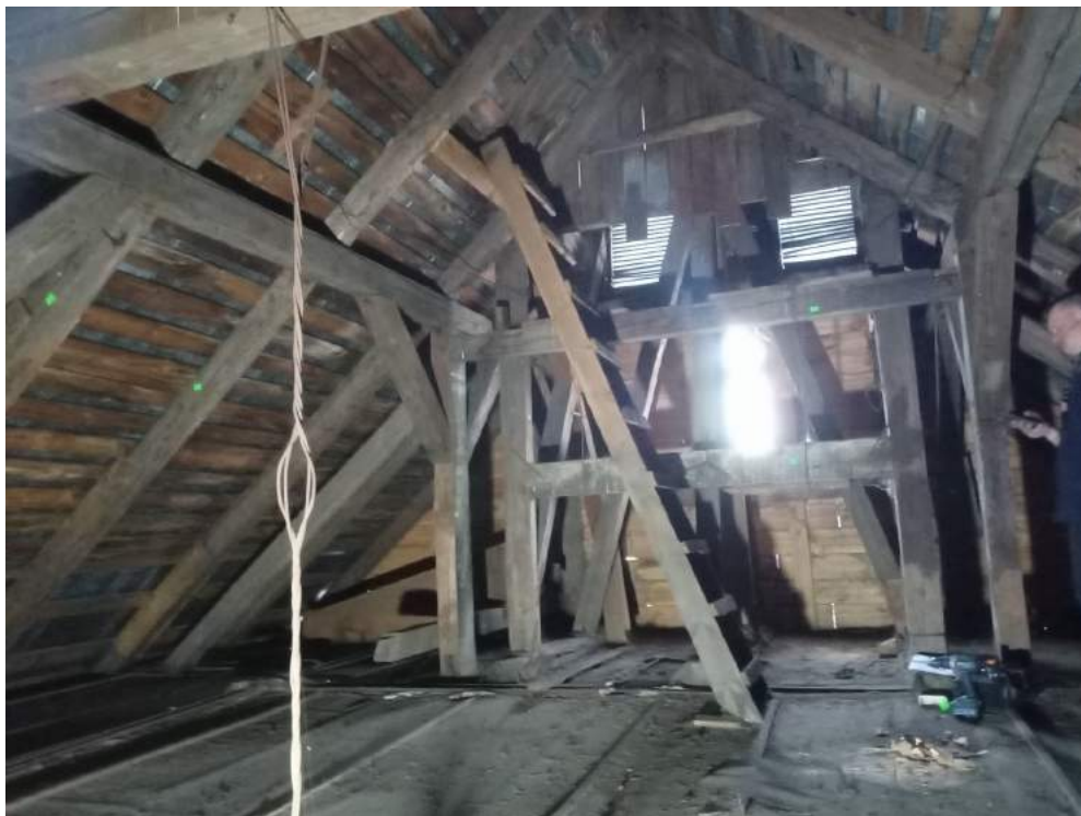
Fot. nr 16 Widok ogólny na więźbę dachową
