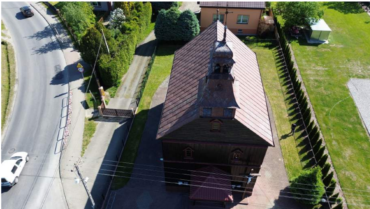
Fot. nr 4 Widok ogólny na dach kościoła i wieżę
