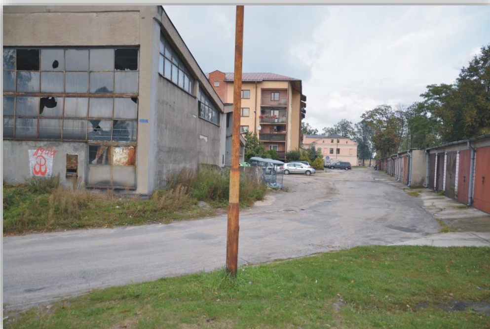
FOT 7 – Wizja terenowa - zdegradowana przestrzeń publiczna w centralnej części miasta w otoczeniu zabudowy mieszkaniowej (fot. własna)
