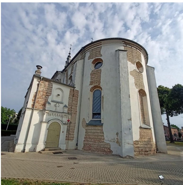
Fot. 51. kościół par. p.w. św. Andrzeja w Złoczewie, widok na elewację wschodnią od południa, miejsce wykonania odkrywek w górnej partii elewacji.
