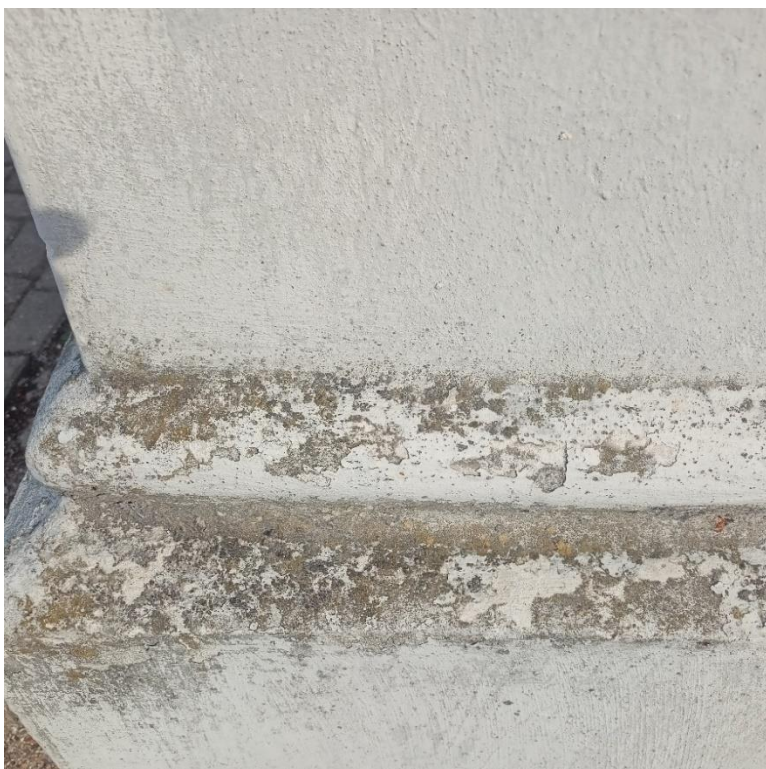
Fot. 38. kościół par. p.w. św. Andrzeja w Złoczewie, porażenie mikrobiologiczne w partiach zawilgoconych.
