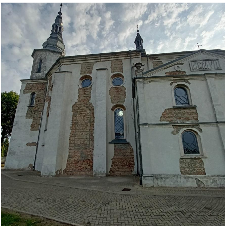
Fot. 53. kościół par. p.w. św. Andrzeja w Złoczewie, widok na elewację południowo-zachodnią.
