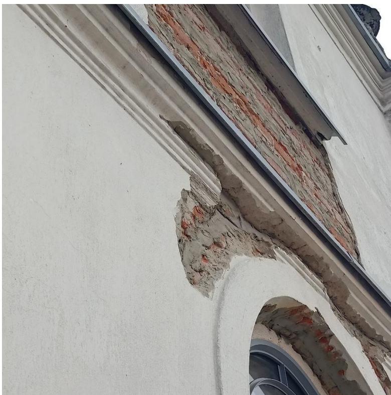
Fot.25. kościół par. p.w. św. Andrzeja w Złoczewie, wtórny tynk wapienno pokryty trzema powłokami malarskimi z faz chronologicznych od czwartej do szóstej.
