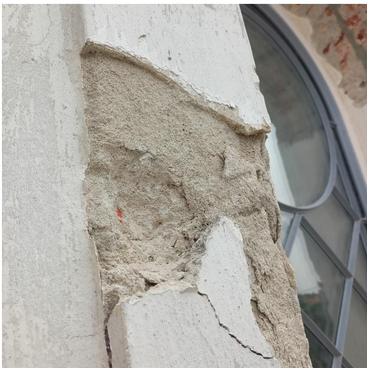
Fot.22. kościół par. p.w. św. Andrzeja w Złoczewie, odkrywka na opasce architektonicznej. Na wtórnym tynku w szarym odcieniu występują trzy współczesne powłoki malarskie. Brak wcześniejszych warstw.
