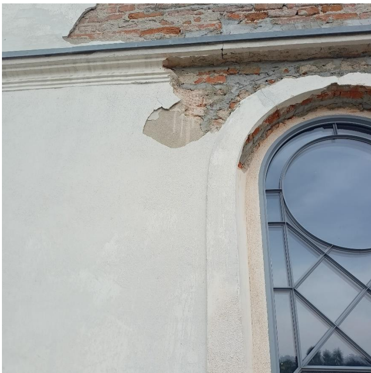
Fot.24. kościół par. p.w. św. Andrzeja w Złoczewie, odkrywka naturalna, miejsce oceny układu warstw dla elementów sztukatorskich. Profilowany gzyms wykonany w jednej wtórnej warstwie narzutu.
