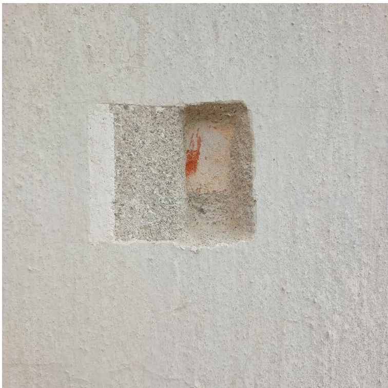
Fot.15. kościół par. p.w. św. Andrzeja w Złoczewie, ściana wschodnia prezbiterium, odkrywka pokazująca wtórny tynk i dwie warstwy współczesnych warstw malarskich w odcieniach bieli. Na oryginalnym wątku ceglany pozostałości (ślady) najprawdopodobniej po historycznym ugrowym tynku.
