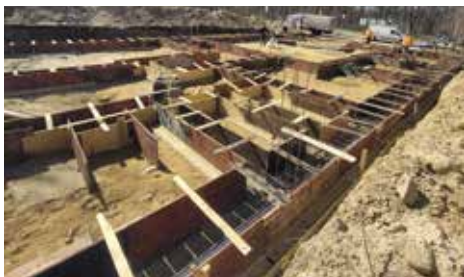
Przygotowanie fundamentów - kwiecień 2022 r.
