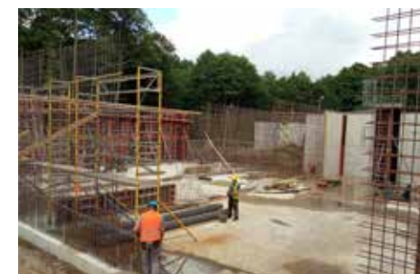
Modernizacja oczyszczalni ścieków w Damnicy
