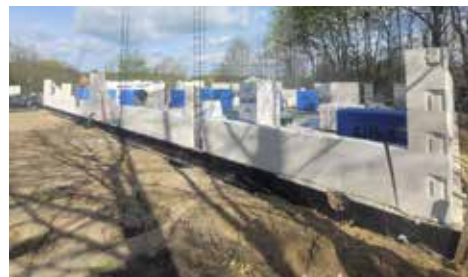
Murowanie ścian budynku - maj 2022 r.
