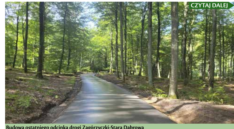
Budowa ostatniego odcinka drogi Zagórzyczki-Stara Dąbrowa
