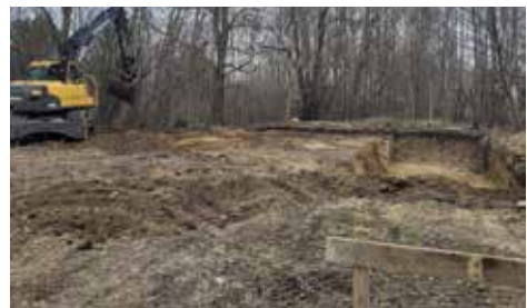
Rozpoczęcie prac budowlanych - kwiecień 2022 r.
