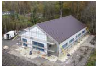
Prace elewacyjne - listopad 2022 r.
