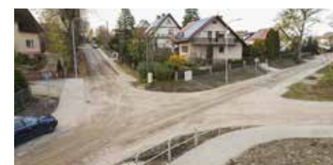
Przebudowa dróg osiedlowych w Damnicy
