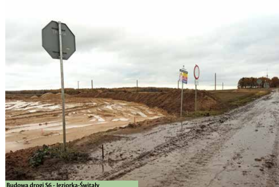
Budowa drogi S6 - Jeziorka-Świtały
