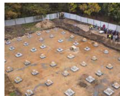
przygotowanie fundamentów - październik 2022 r.
