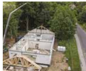
Przygotowanie konstrukcji dachowej - lipiec 2022 r.
