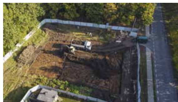
rozpoczęcie prac budowlanych - październik 2022 r.
