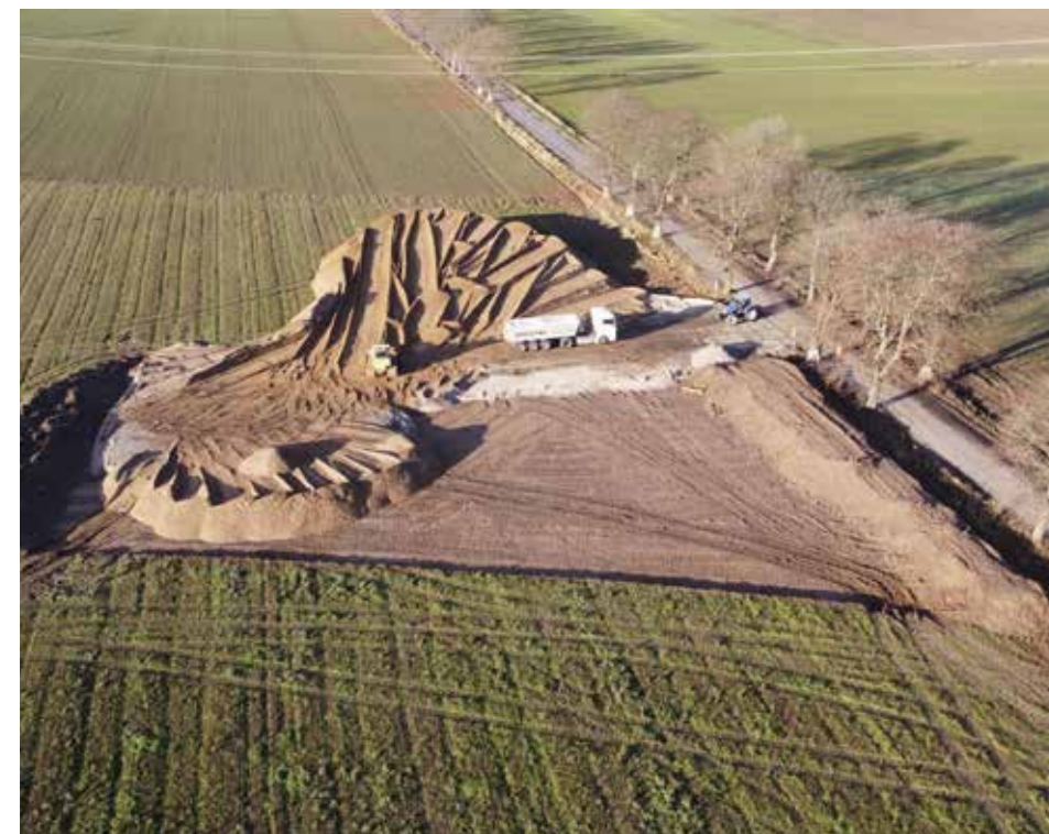
Budowa drogi S6 - węzeł Budy
