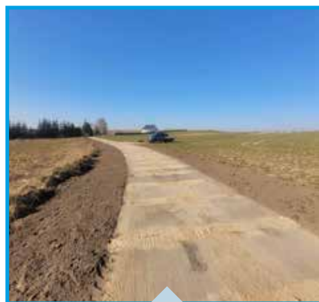
(2022) Modernizacja drogi w Zagórzyczy: 305 m nawierzchni z płyt, wartość inwestycji: 34.686,00 zł
