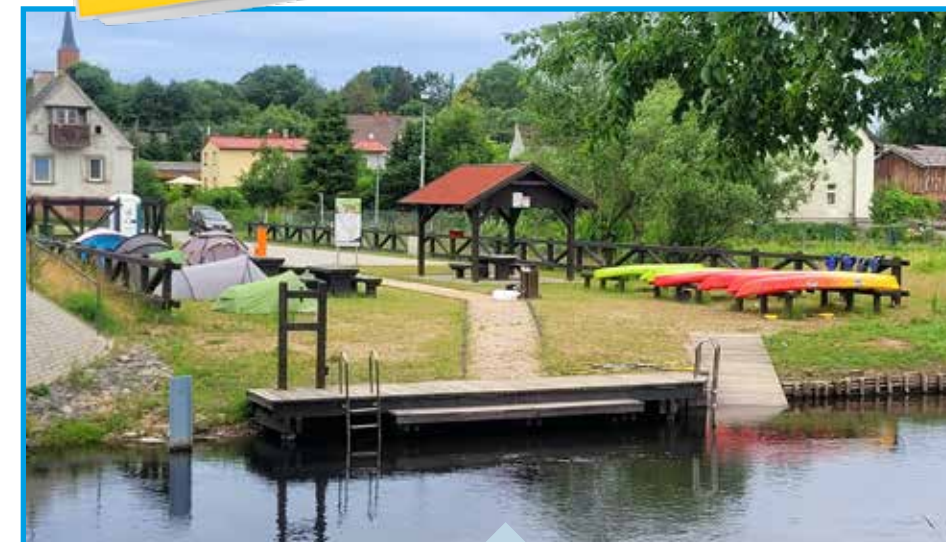
(2021) Budowa stacji kajakowej w Damnie: wartość inwestycji – 261.447,06 zł, w tym 77,9% dofinansowania (203.542,62 zł)
