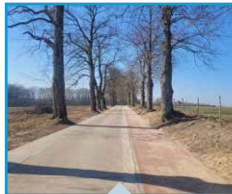
(2022) Przebudowa drogi Zagórzycza – Karzniczka wraz ze ścieżką pieszo-rowerową: 900 m nawierzchni asfaltowej i polbruk, wartość inwestycji – 447.997,29 zł, w tym 39,6% dofinansowania (177.400,00 zł)
