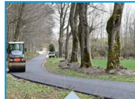
(2020) Przybudowa drogi w Domaradzu: 215 m nawierzchni asfaltowej, wartość inwestycji – 93.928,52 zł
