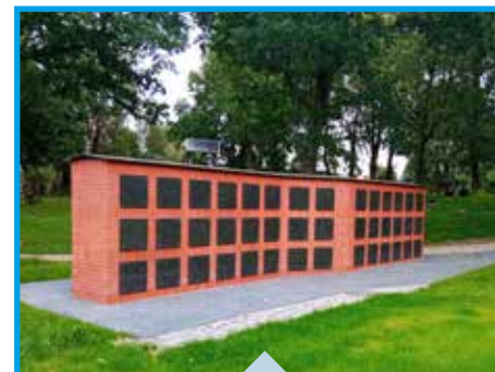
(2023) Budowa kolumbarium na cmentarzu w Damnicy: wartość inwestycji – 248.457,56 zł
