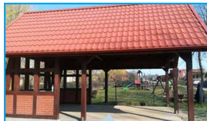
(2019) Budowa wiaty biesiadnej w Karznicze: wartość inwestycji – 79.057,58 zł, w tym 12,6% dofinansowania (10.000,00 zł)
