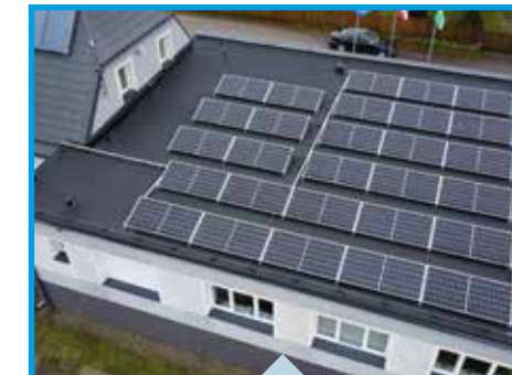
(2023) Zakup i montaż paneli fotowoltaicznych na budynku Urzędu Gminy Damnica i Zakładu Gospodarki Komunalnej w Damnicy: wartość inwestycji – 117.820,34 zł, w tym 75,6% dofinansowania (89.027,90 zł)
