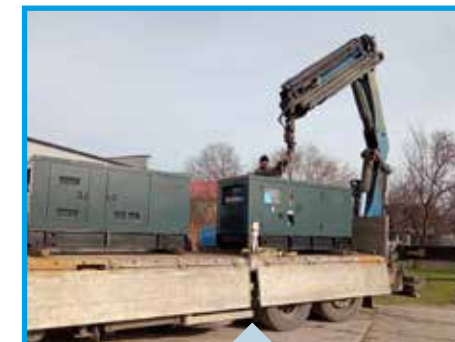
(2023,2024) Zakup dwóch agregatów prądotwórczych o mocy 34 kW i 53 kW: wartość inwestycji – 79.370,03 zł, w tym 94,5% dofinansowania (75.003,03 zł)
