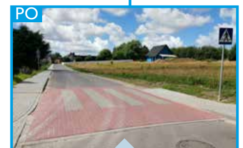
(2020) Przebudowa ulicy Leśnej i ulicy Parkowej w Damnicy: 800 m nawierzchni asfaltowej i polbruk, wartość inwestycji – 713.138,33 zł, w tym 41,8% dofinansowania (298.400,00 zł)
