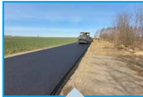
(2022, 2020) Przebudowa drogi Saborze – Paprzyce: 510 m nawierzchni betonowej i 370 nawierzchni asfaltowej, wartość inwestycji – 633.591,68 zł, w tym 44,1 % dofinansowania (279.489,00 zł)
