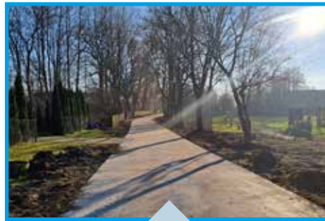
(2022) Przebudowa drogi przy boisku w Biecinie: 140 m nawierzchni betonowej, wartość inwestycji – 59.941,17 zł
