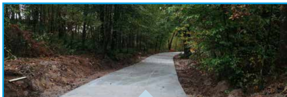
(2021) Budowa drogi Strzyżyno – Dąbrowka: 500 m nawierzchni betonowej, wartość inwestycji – 313.559,49 zł, w tym 42% dofinansowania (131.665,39 zł)
