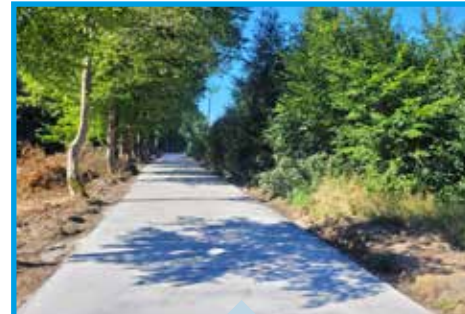
(2022) Budowa drogi przy boisku w Zagórzyczy: 255 m nawierzchni betonowej, wartość inwestycji – 102.100,73 zł
