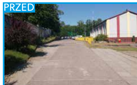
(2021) Modernizacja drogi w Dąbrowce Kolonii w kierunku Strzyżyna: 110 m nawierzchni z kruszywa, wartość inwestycji – 20.000,00 zł
