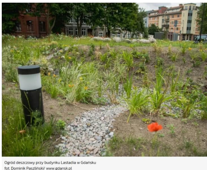
Ogród deszczowy przy budynku Lastadia w Gdańsku fot. Dominik Pasztiński/ www.gdansk.pl
