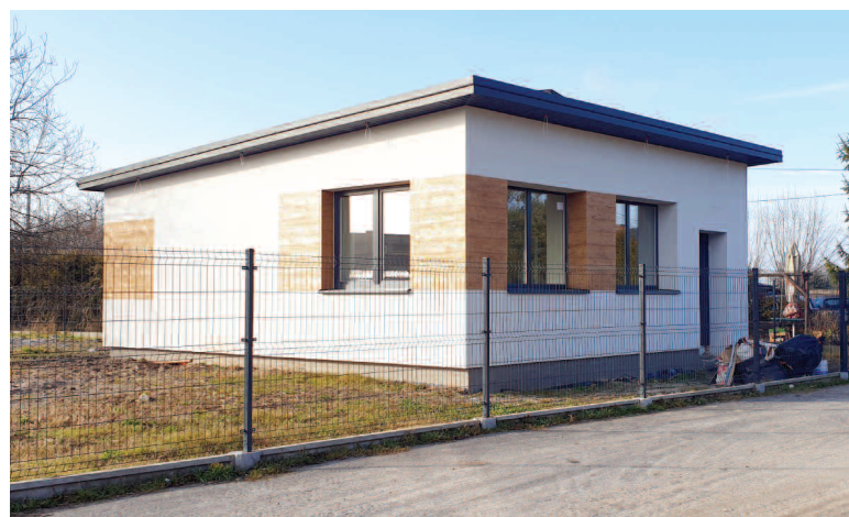
Ocieplona świetlica w Czarnym Lesie
