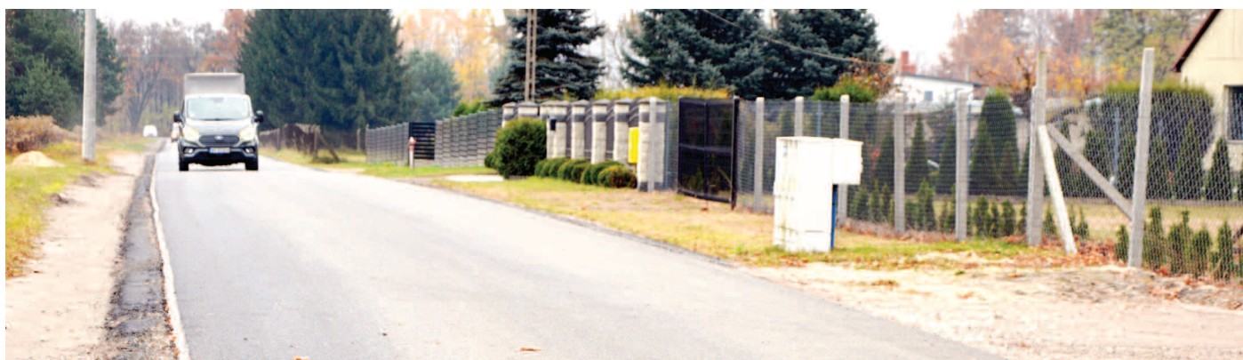
Wyasfaltowany odcinek drogi w Karolinie
