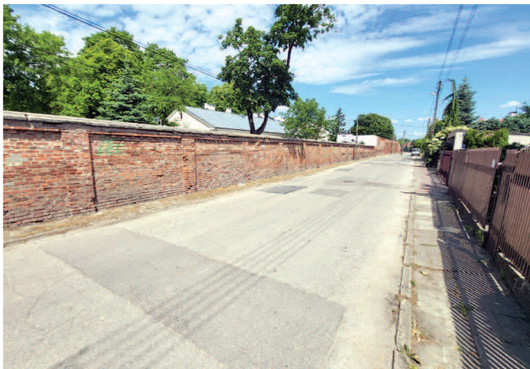
Ulicę Lipkowską pokryje nowa nakładka asfaltowa
