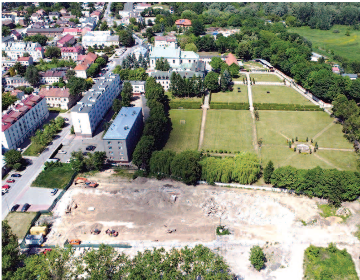
Na placu budowy trwają roboty ziemne i brukarskie (fot. Jacek Kaczanowski)
