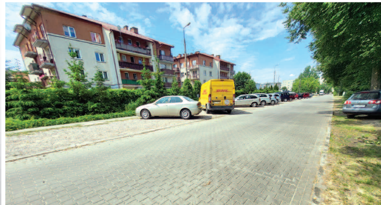
Na ulicy Chopina powstaną miejsca parkingowe z prawdziwego zdarzenia
