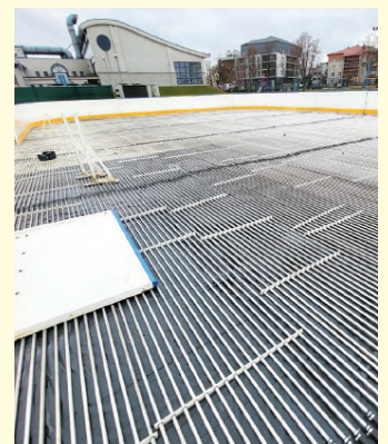
12 grudnia trwa montaż
