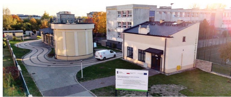
Stacja Uzdadniania Wody „Kalwaryjska” w Górze Kalwarii przeszła modernizację
