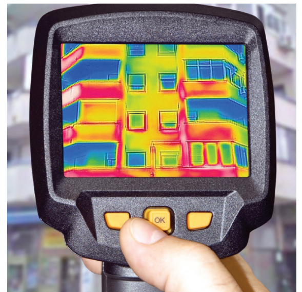
Badanie termowizyjne budynku pokazuje „mapę temperatur”
