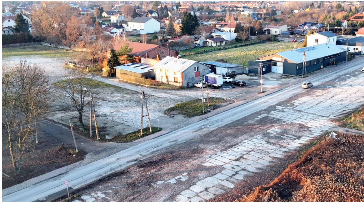
Prace, które rozpoczną się za kilka miesięcy, dobiegną końca w 2026 roku (fot. Sebastian Kaczmarek)
