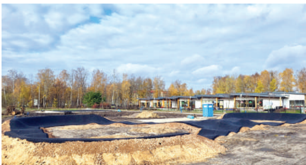
>>> Budowa toru rowerowego i boiska do koszykówki w Górze Kalwarii
