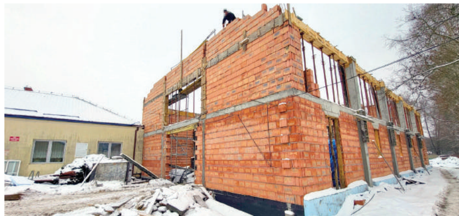
>>> Budowa szkolnej sali gimnastycznej w Czaplinku
