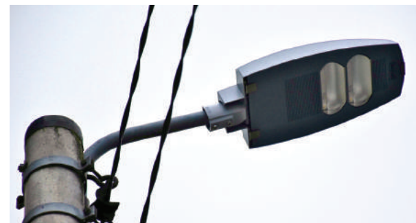
>>> Modernizacja oświetlenia ulicznego
