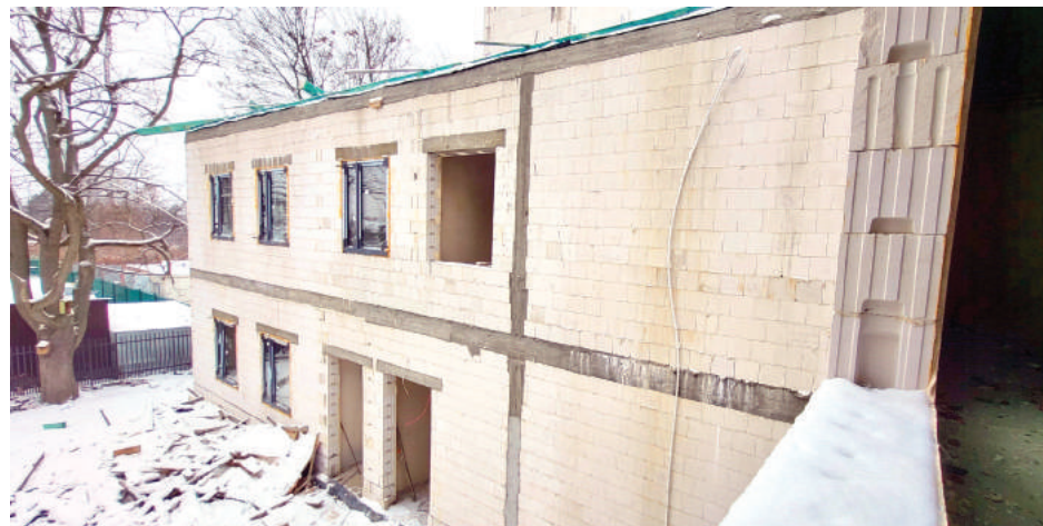
>>> Rozbudowa Zespołu Szkolno-Przedszkolnego w Kątach
