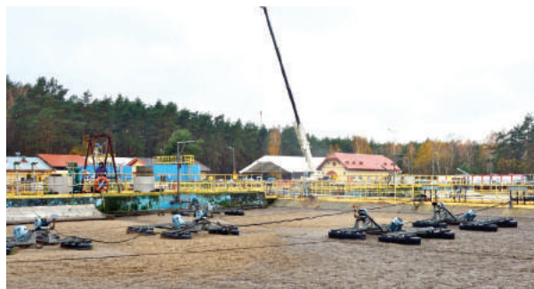
>>> Rozbudowa oczyszczalni ścieków w Moczydłowie
