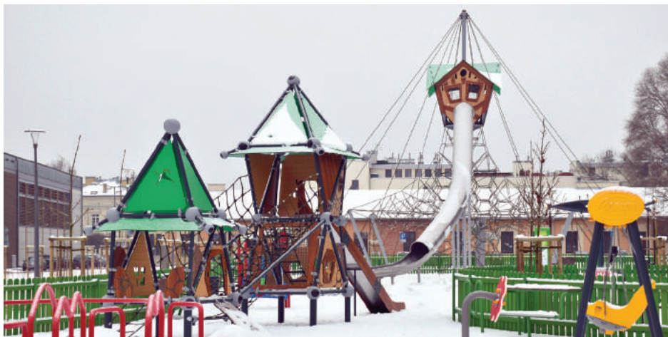
>>> Budowa wielkiego miejsca rekreacji w Górze Kalwarii
