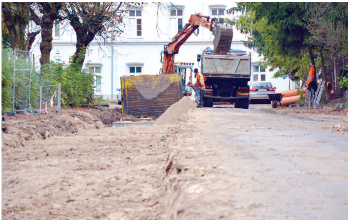
Budowa kanalizacji deszczowej w byłych koszarach
