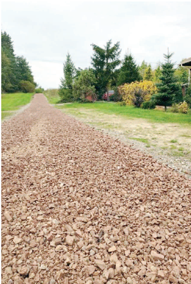
Utwardzona droga lokalna w Brześciach
