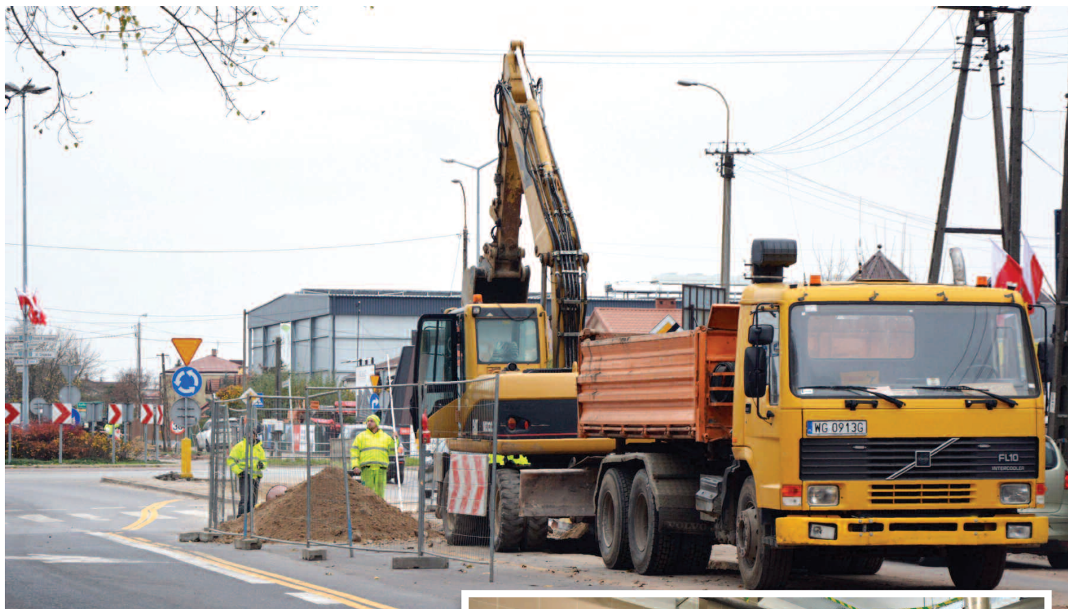
Dobiegają końca prace polegające na przebudowie sieci wod.-kan. w Górze Kalwarii
