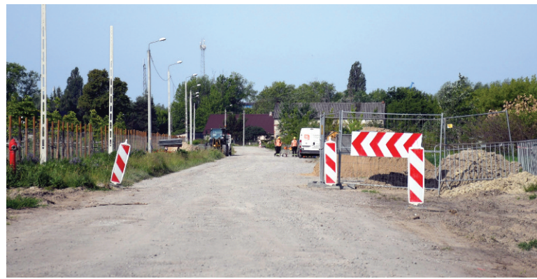
Rozpoczęła się gruntowna modernizacja gminnej ul. Długiej na granicy Góry Kalwarii z Moczydłowem
