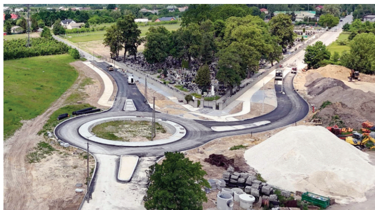
Województwo mazowieckie kończy przebudowywać drogę nr 683 w Sobikowie i Czaplinku
