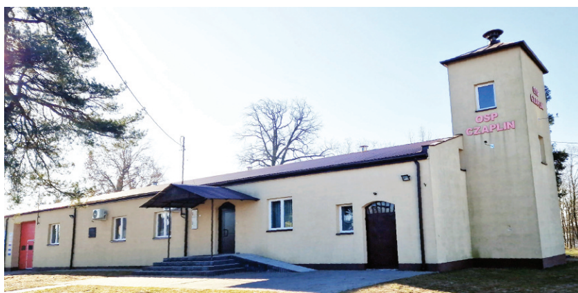
Urząd miasta zleci prace remontowe w siedzibie OSP Czaplin
