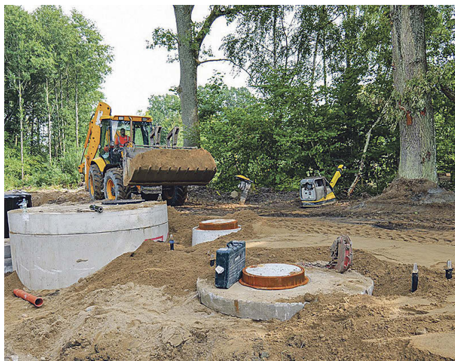
Montaż zbiornika retencyjnego w Domasławicach
