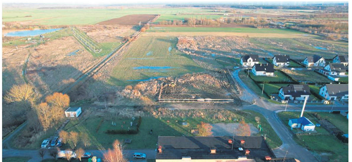
Na placu budowy rozpoczęły się wstępne prace przygotowawcze do realizacji inwestycji.
