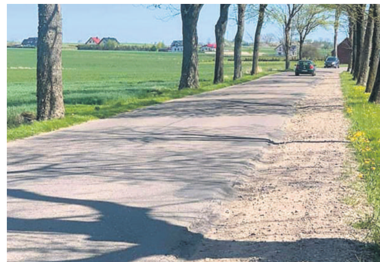
Na drodze 203 pozostał ostatni odcinek do wyremontowania i będzie to nowoczesna arteria komunikacyjna dla mieszkańców i turystów.
