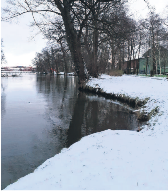
Brzeg przed rozpoczęciem prac
