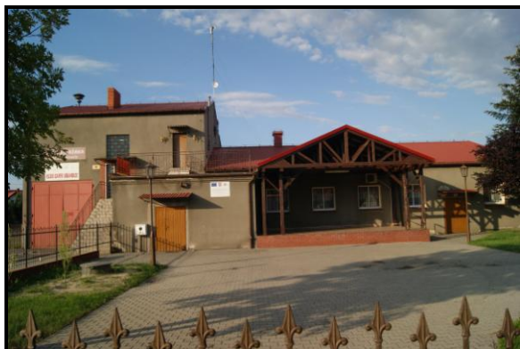
Budynek świetlicy wiejskiej z miejscem spotkań mieszkańców
