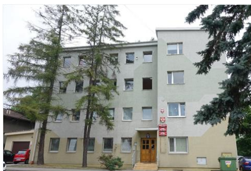
budynek przy ul. Słowackiego 36. przed modernizacją 36. po modernizacji
