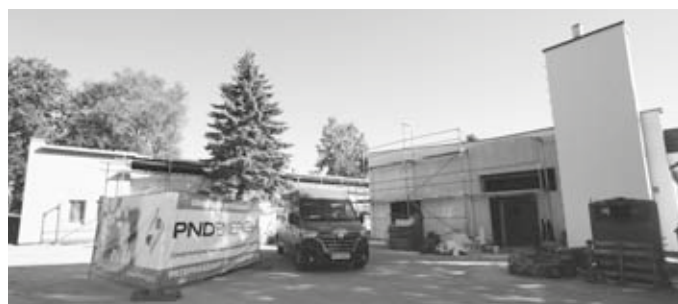
Trwa termomodernizacja obiektów ZPO i OK w Miłkach
