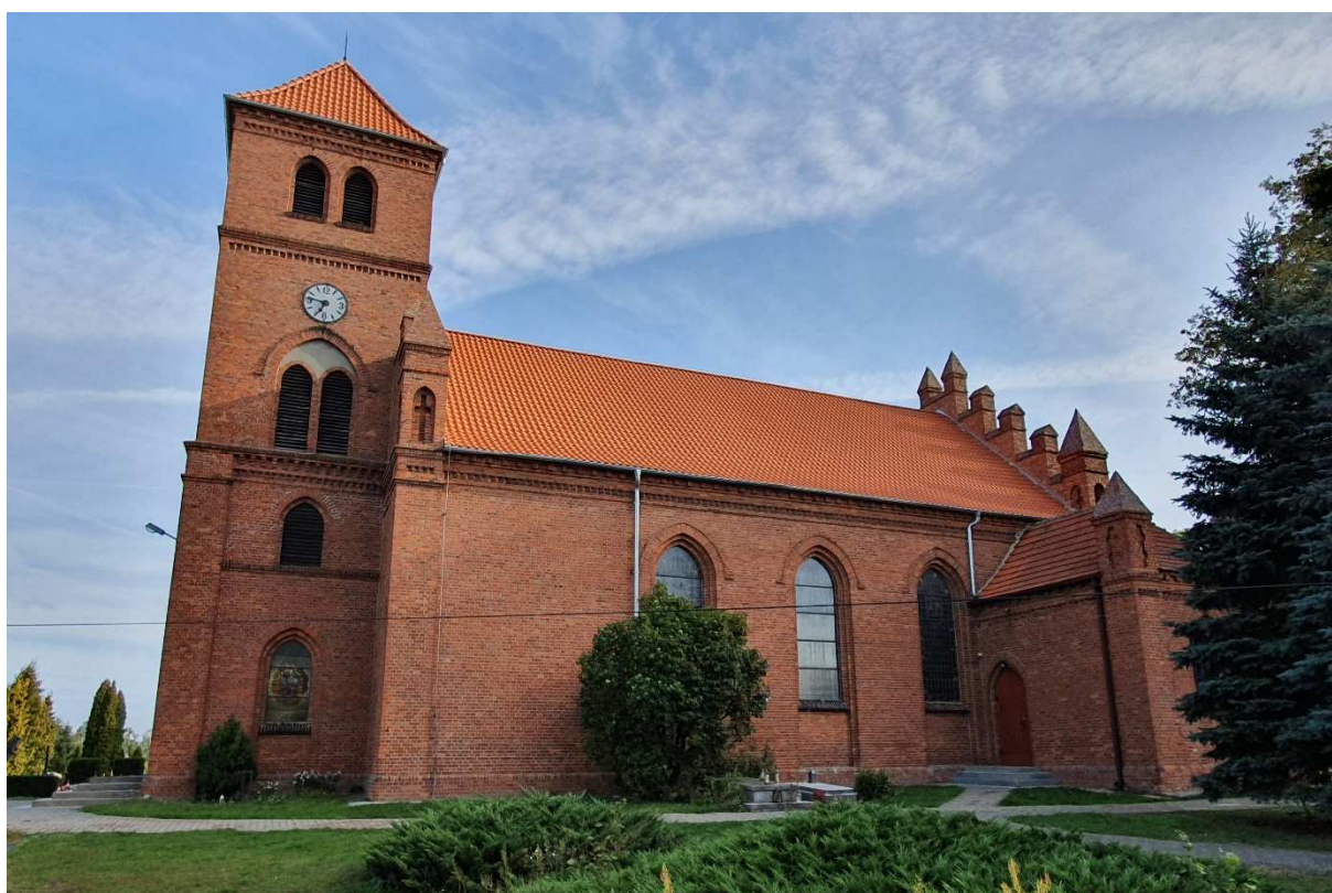
Fot.2. Łążyń, kościół pw. św. Walentego. Widok od strony południowej.
