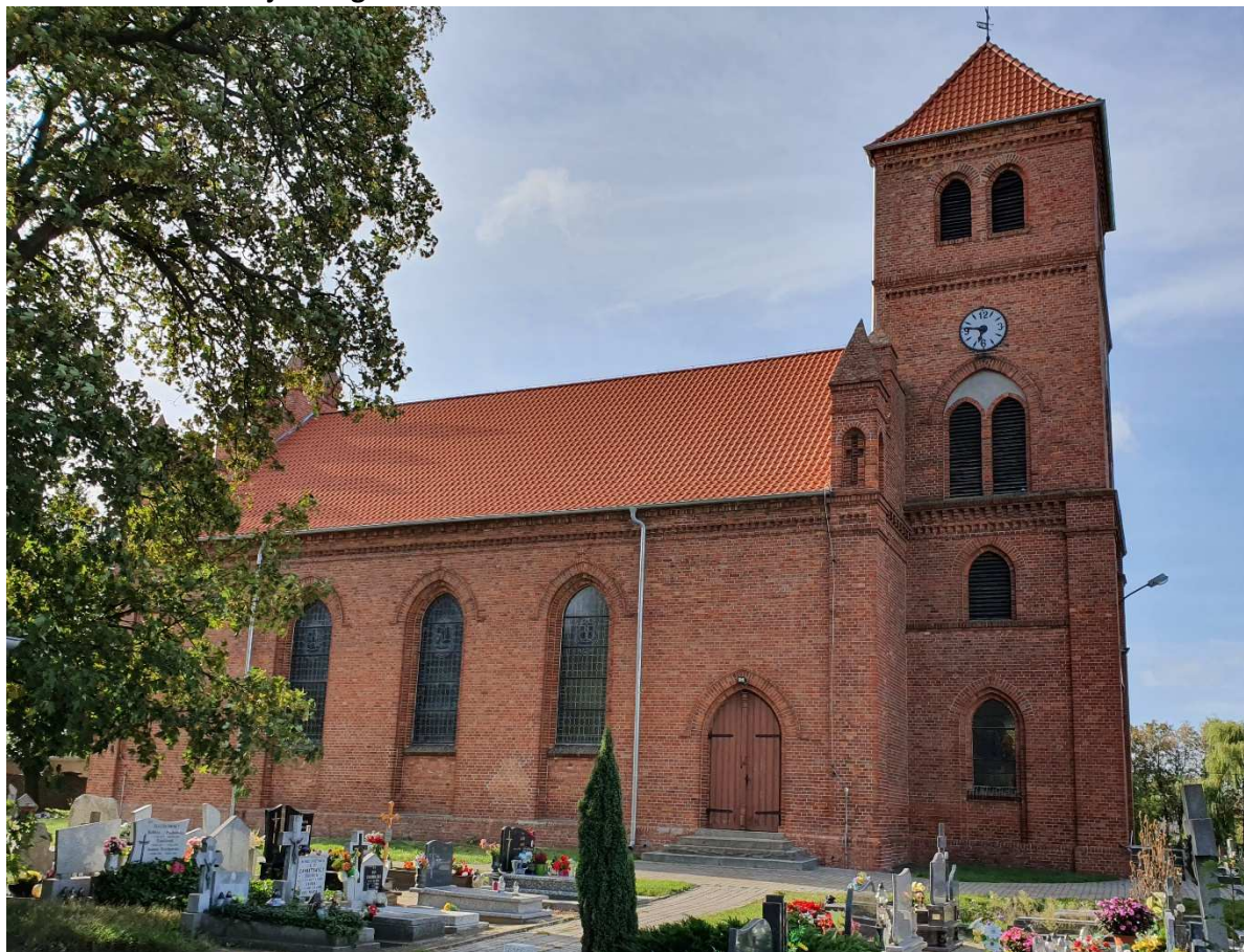
Fot.1. Łążyń, kościół pw. św. Walentego. Widok od strony północnej.
