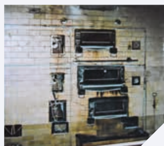
Wyremontowany piec ceramiczny. Obecnie zastąpiły go piece olejowe
