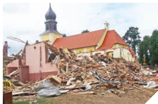
2017 rok i rozbiórka budynku po zniszczeniach po nawałnicy
