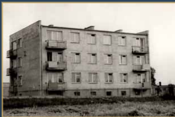
Budynek mieszkalny SKR w Gostycynie, 1975 r.
