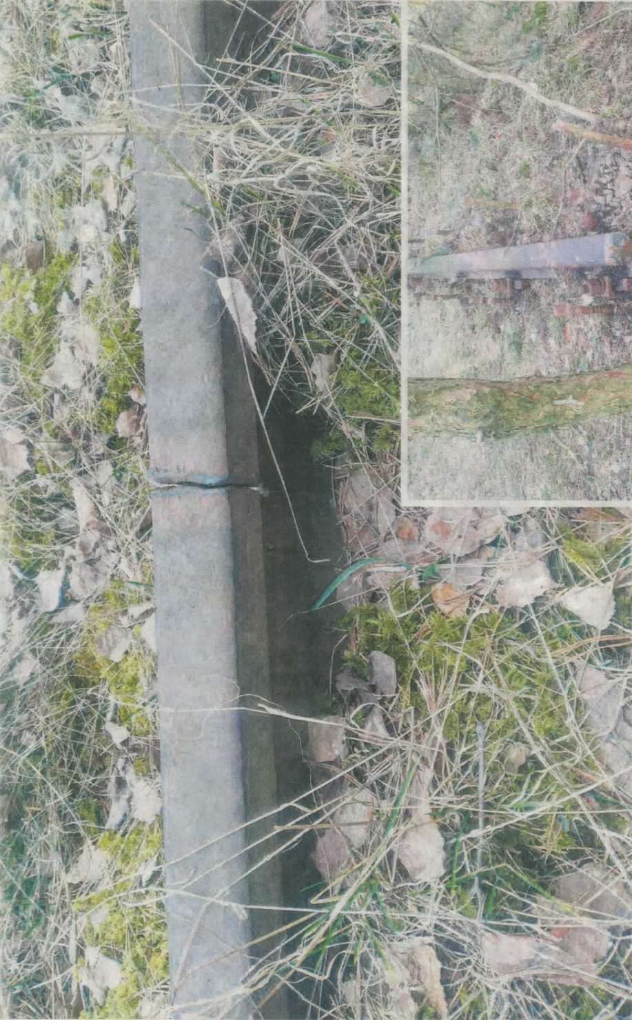
Przecięty element gotowy do rozbiórki.
