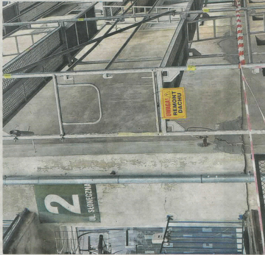
Prace przy ul. Słonecznej 2 już się rozpoczęły.
