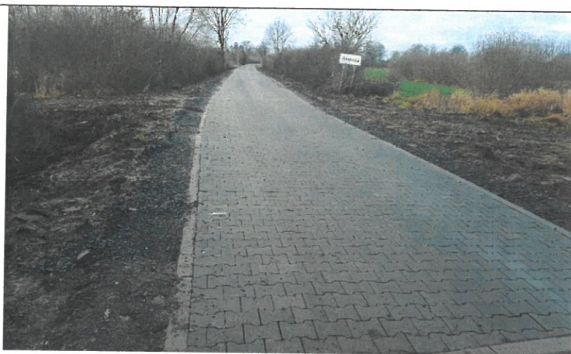
b) Remont drogi gminnej w sołectwie Głęboka
