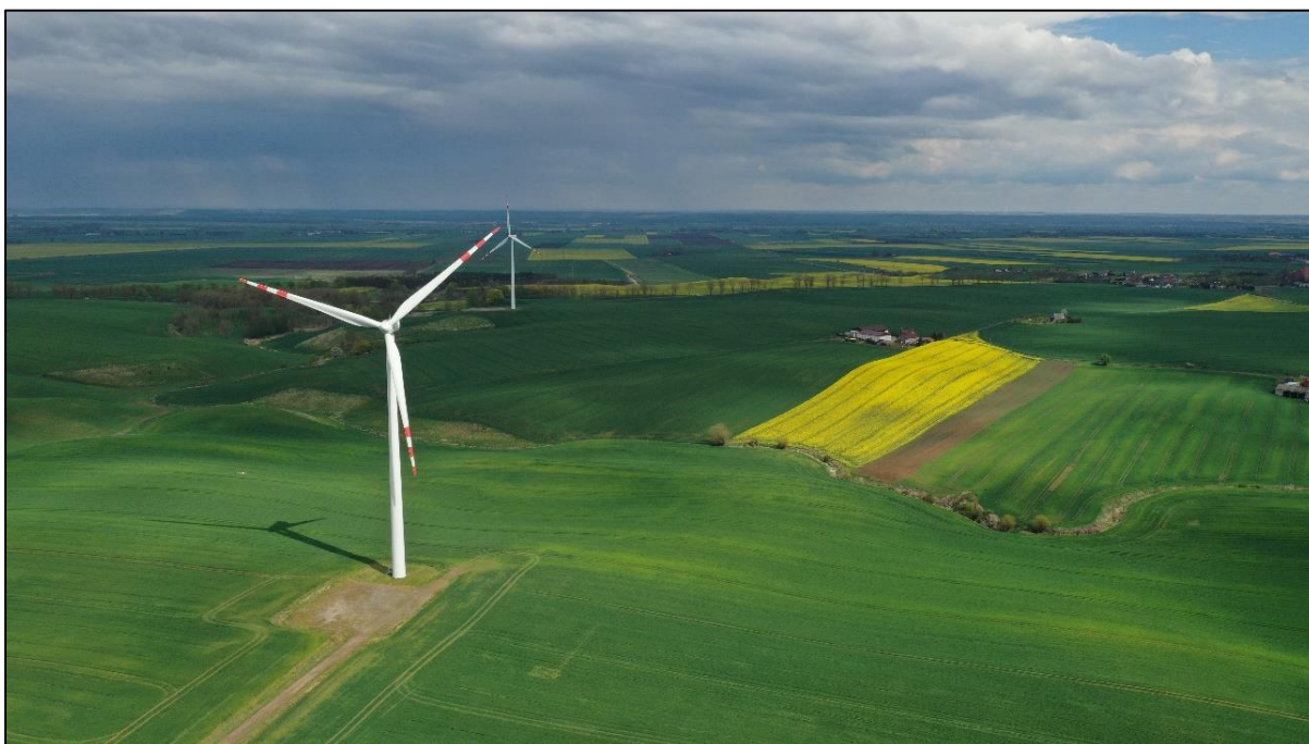
Farma wiatrowa w obrębie geodezyjnym Pomyje
