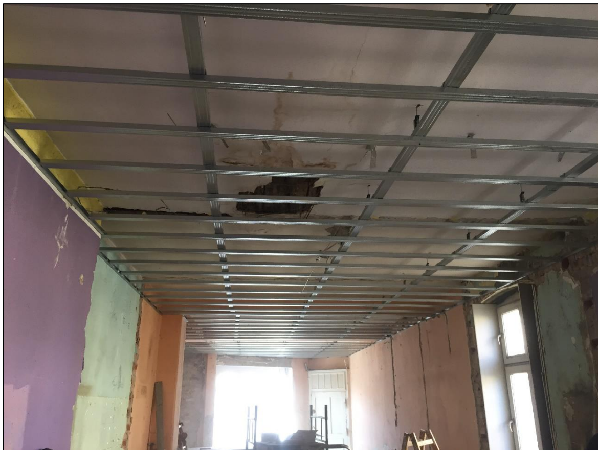
Lokal w Pelplinie przy Placu Grunwaldzkim 8 na początku prac modernizacyjnych
