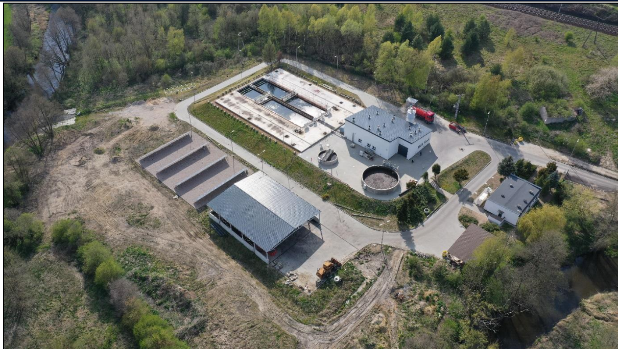
Przebudowywana oczyszczalnia ścieków w Pelplinie – projekt finansowany ze środków Programu Operacyjnego Infrastruktura i Środowisko na lata 2014 – 2020
