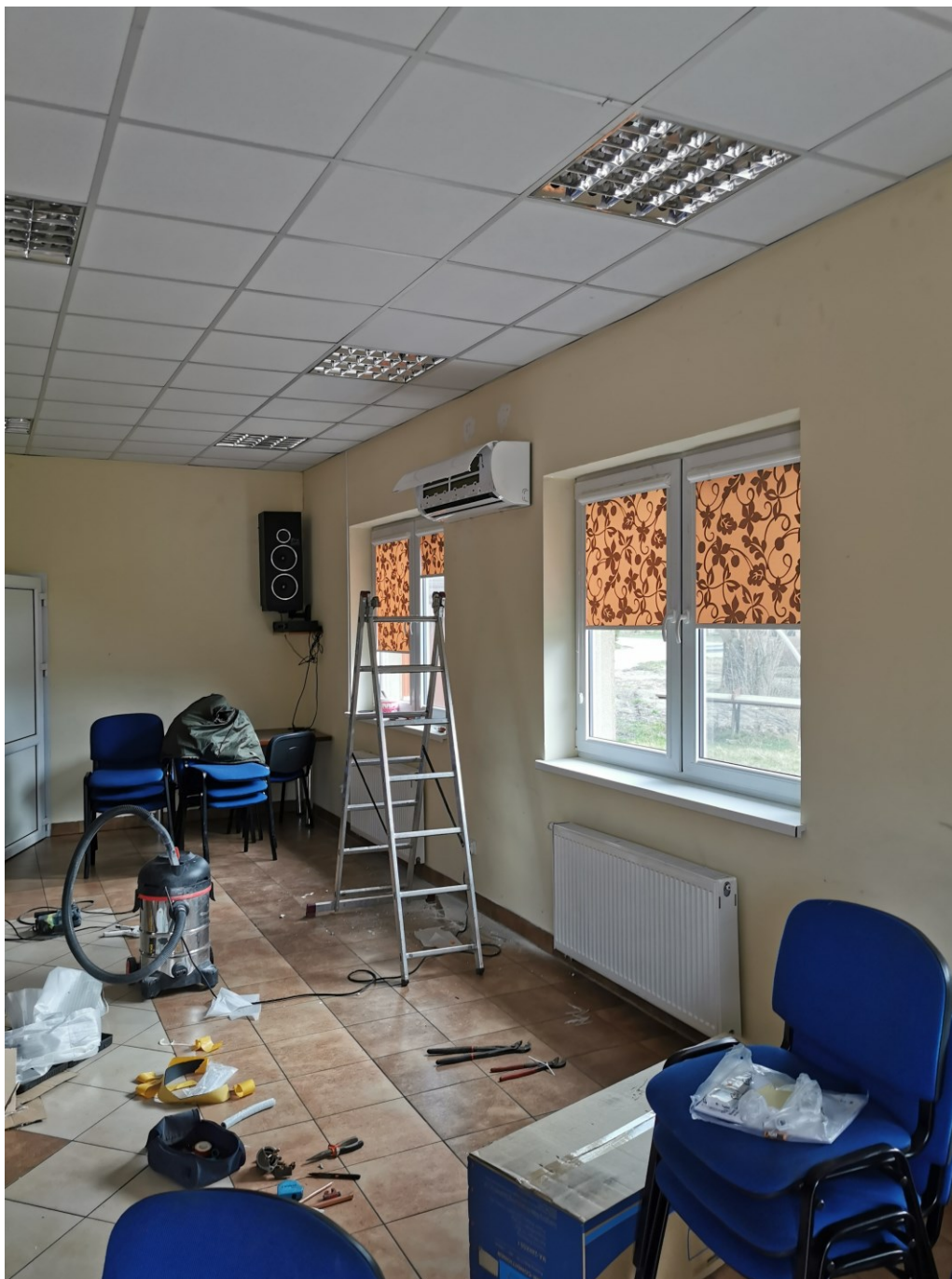
13.03.2020 r. – montaż klimatyzacji w świetlicy wiejskiej w Pomyjach
