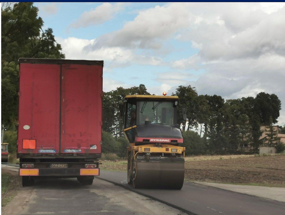
Wrzesień 2020 – prace związane z modernizacją drogi wojewódzkiej Rudno – Wielki Garc
