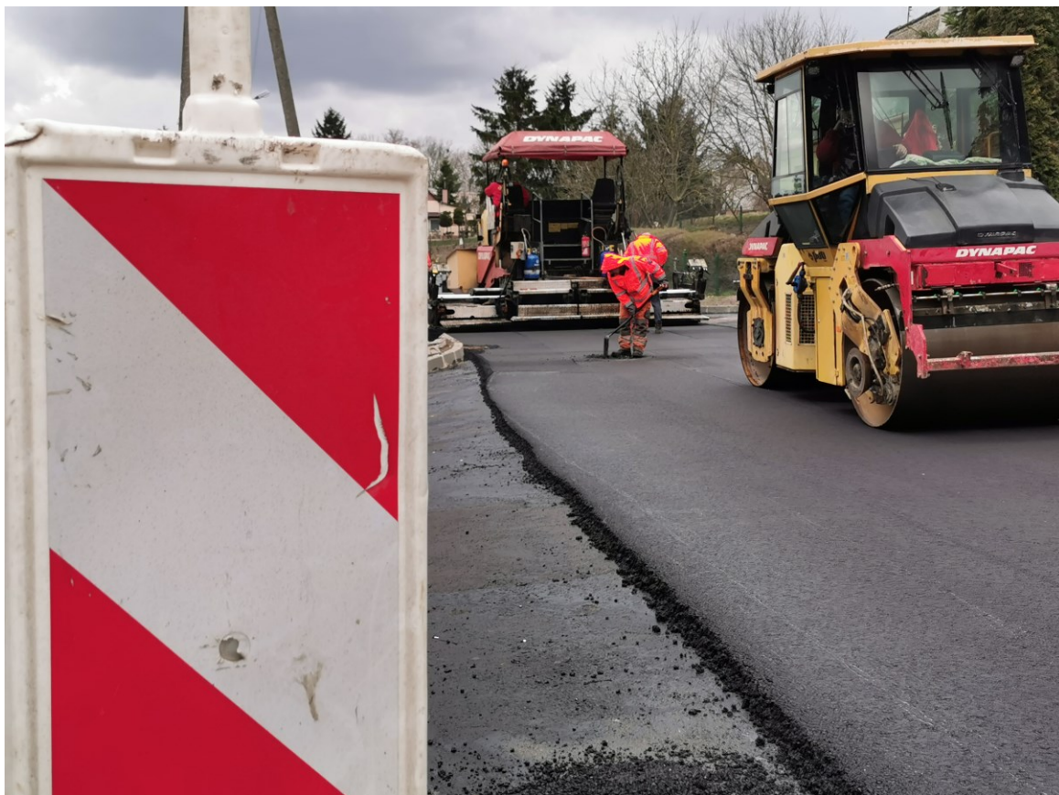
marzec 2020 r. – asfaltowanie nawierzchni podczas budowy drogi gminnej w centrum Wielkiego Garca – inwestycja finansowana w 50% z Funduszu Dróg Samorządowych (łącznie nakłady finansowe: 1.510.000 zł; środki własne gminy: 798.524 zł)
