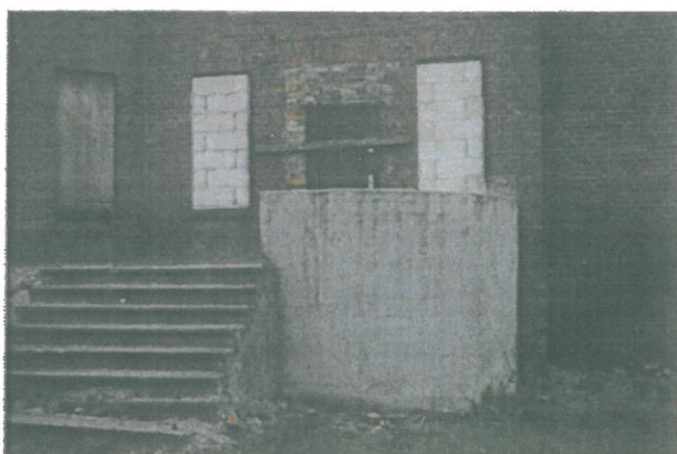
Wejście do budynku
