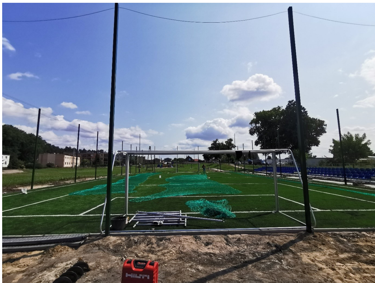
22.07.2021 r. – budowa boiska o sztucznej nawierzchni przy osiedlu Pólko w Pelplinie
