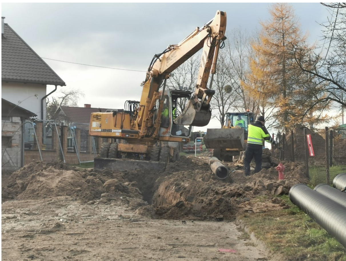
22.11.2021 r. – budowa drogi gminnej w centrum Gręblina
