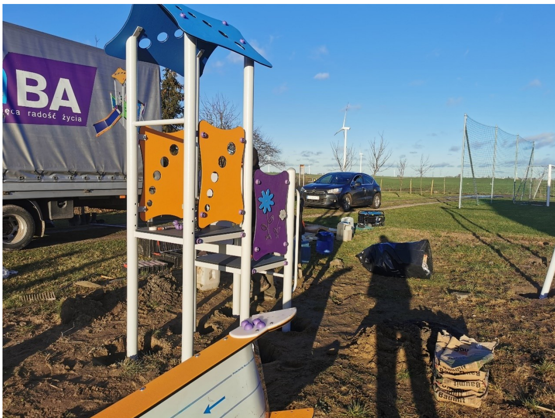
17.10.2021 r. – montaż placu zabaw przy świetlicy w Janiszewie
