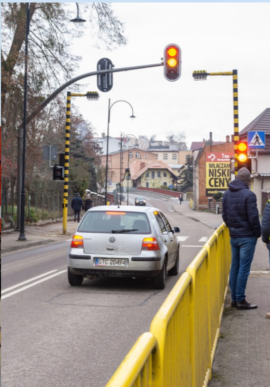
Inteligentne oświetlenie przejścia dla pieszych
