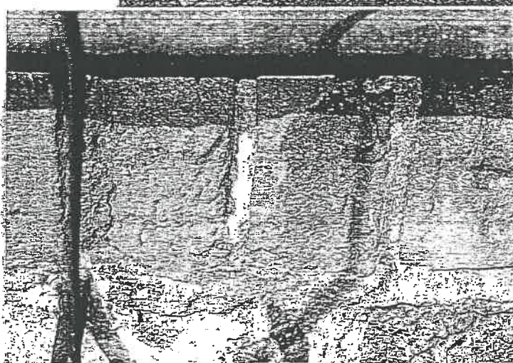
Wtórne spoiny, szczelne zamknięcie cokołu nowym chodnikiem i obróbką po ułożeniu.
