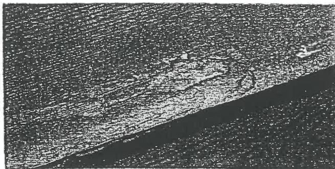
fot. Porażenie elementów wykończeniowych (parapetu, ławki i odbudowy ołtarza głównego) przez owada ksylofaga „Kołatka domowego”.
