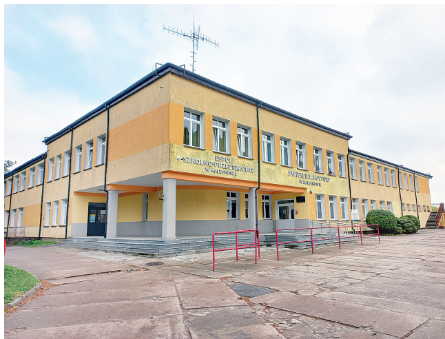
Termomodernizacja szkoły w Malechowie
