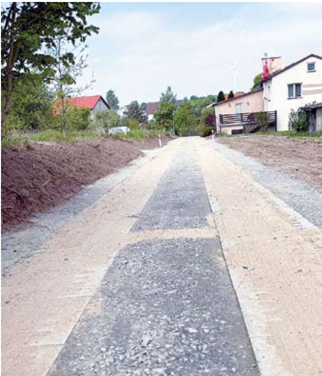
Droga wewnętrzna w Malechowie z płyt yomb
