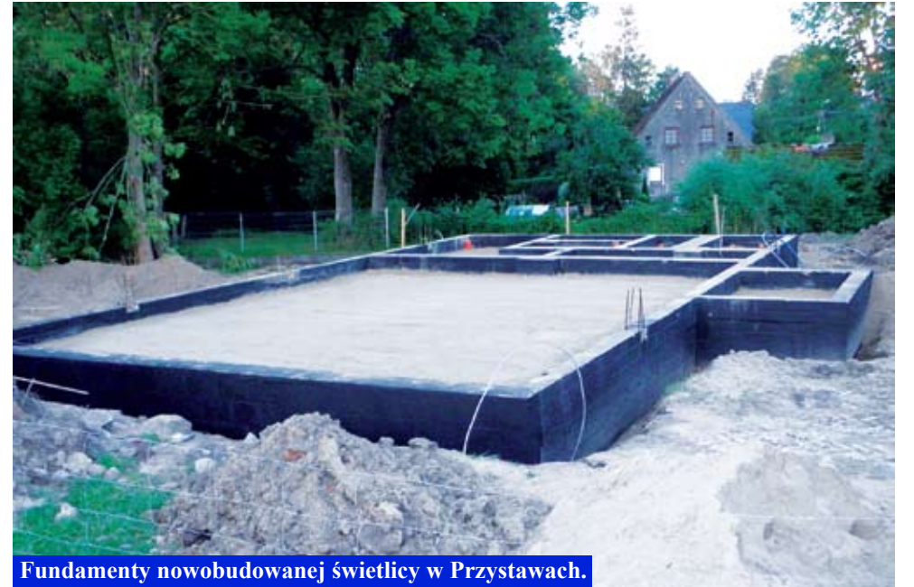
Fundamenty nowobudowanej świetlicy w Przystawach.
