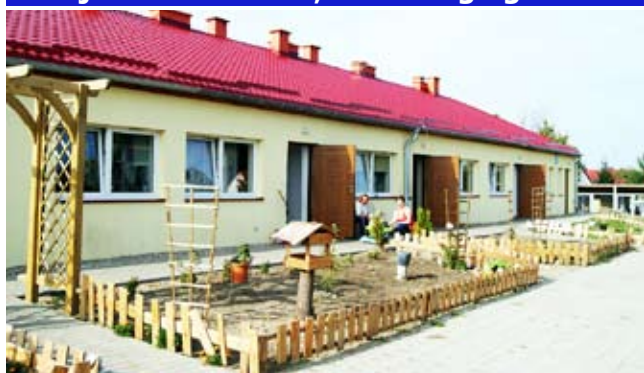
Budowa mieszkań socjalnych w Laskach - 921 177,82 zł, dofinansowanie - 368 102,65 zł
