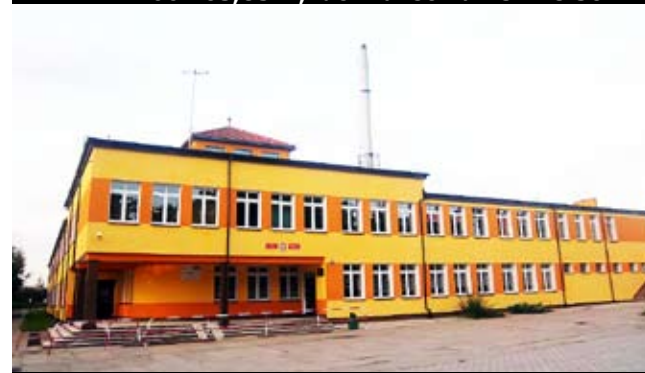
Termomodernizacja Gimnazjum w Malechowie - 567 423,63 zł
