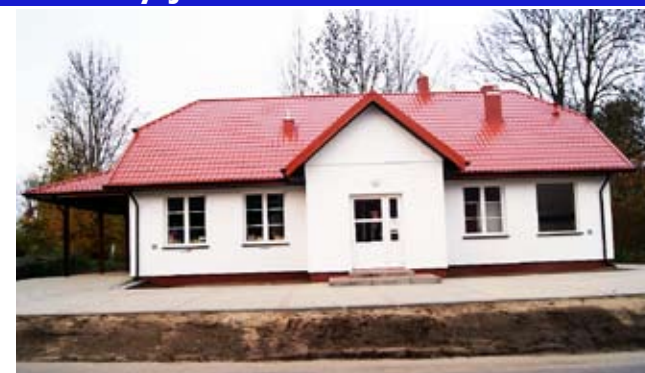
Budowa świetlicy w Przystawach - 330 000 zł, dofinansowanie - 192 220 zł
