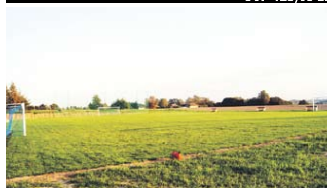
Budowa boiska w Przystawach - 140 059,61 zł, dofinansowanie - 91 095 zł
