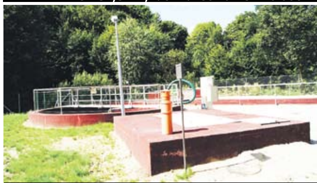
Modernizacja oczyszczalni w Malechowie - 1 393 307,3 zł, dofinansowanie - 840 000 zł
