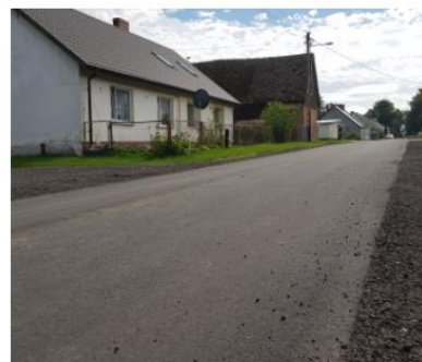
Droga w m. Podgórki
