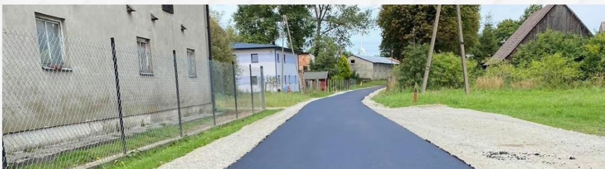
Wyremontowana droga w Darskowie
