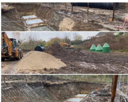
Budowa oczyszczalni ścieków w Podgórkach
