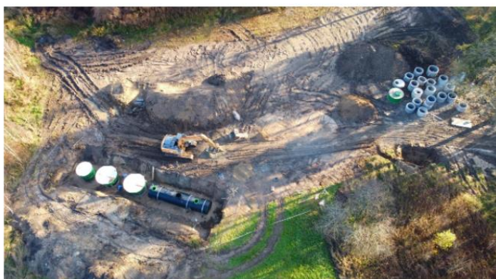
Budowa oczyszczalni ścieków w Podgórkach
