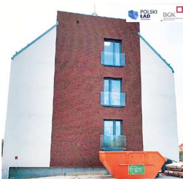
Nowa elewacja budynku urzędu
