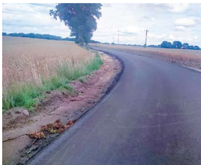
Droga Ostrowiec - Podgórki
