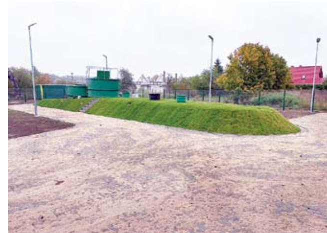
Oczyszczalnia w Sulechówku
