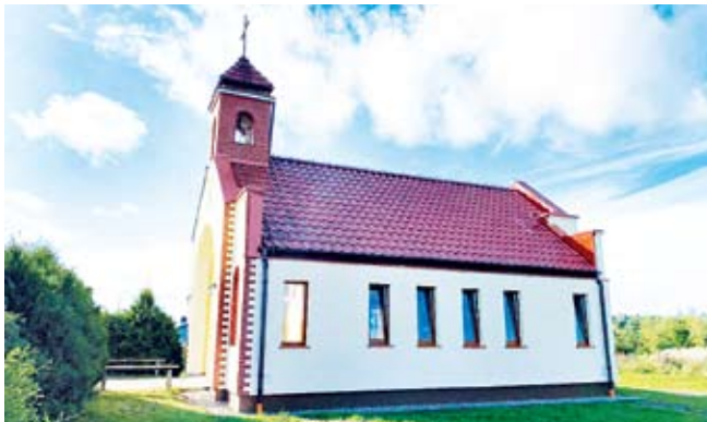
Dom przedpogrzebowy po remoncie
