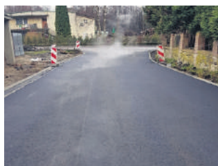
Remont dróg gminnych - ul. Sienkiewicza i ul. Robotnicza Wartość zadania dofinansowanie 531.704,92 zł; wartość całkowita: 759.578,46 zł - dofinansowanie: 531.704,92 zł, - wkład własny: 227.873,54 zł
