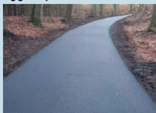
Remont i modernizacja nawierzchni drogi gminnej na odcinku drogi Porost - Buszynko w porozumieniu i z dofinansowa- nia Nadleśnictwa Bobolice: Wartość zadania 100.000 zł
