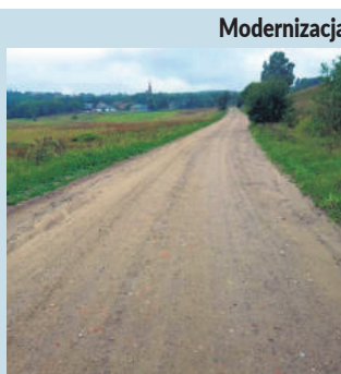
Modernizacja drogi gminnej Bobolice - Chlebowo - Głódowa Wartość zadania: 43.050 zł
