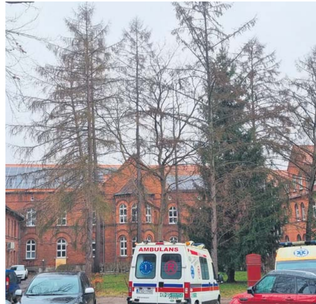
Już wkrótce w budynku szpitala w Polczynie-Zdroju rozpocznie się remont dachu i pomieszczeń
