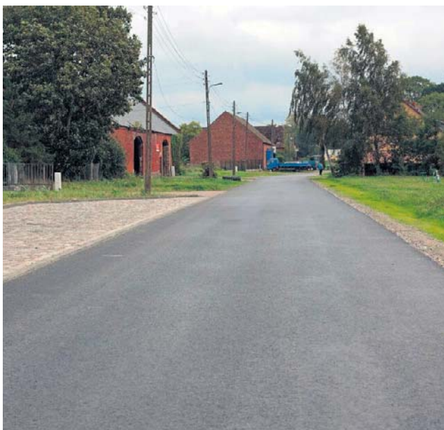
Zakończenie inwestycji drogowej w Trzebuszu
