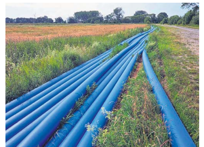
Budowa kolektora ściekowego Mrzeżyno – Trzebiatów
