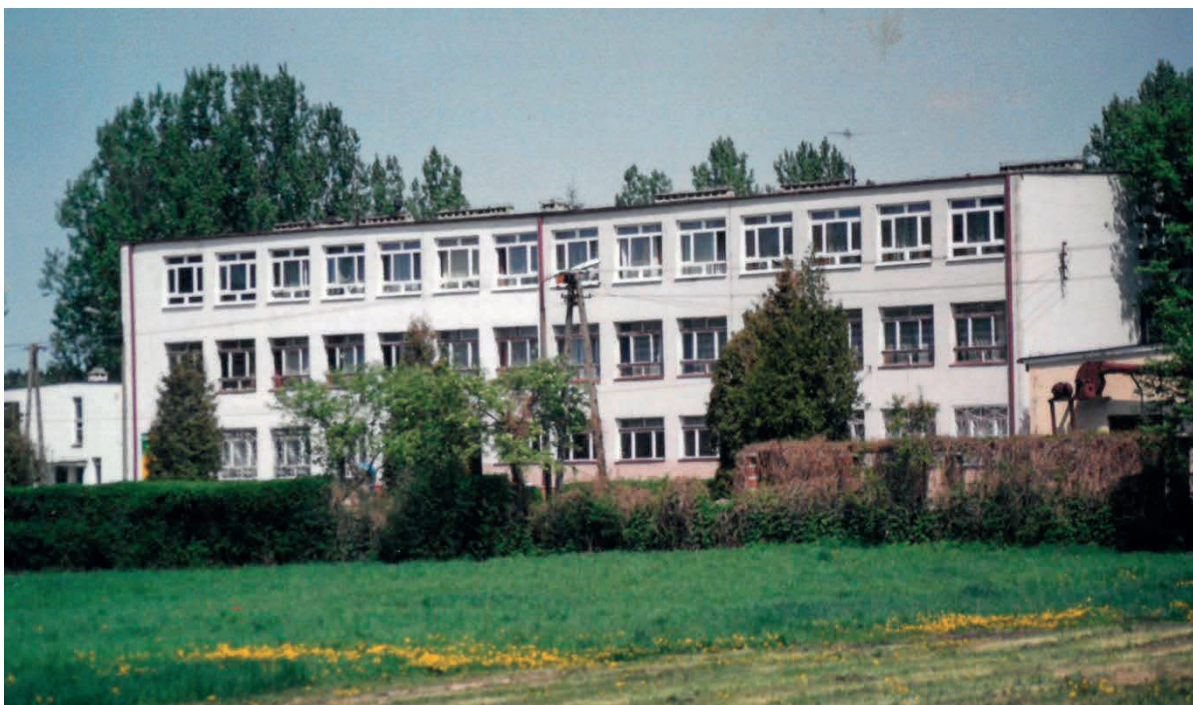
Budynek szkoły z przełomu lat 80. i 90. XX w.
