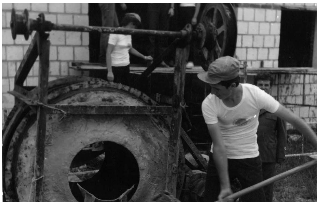
Uczniowie pomagają przy budowie nowego budynku
