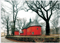
Fot. 6. Kościół św. Anny nad Wkrą (fot. J. Zdunkiewicz)
