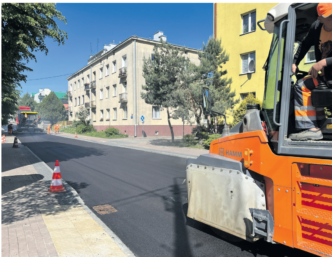
Remont nawierzchni ul. Starostwo w Grójcu
