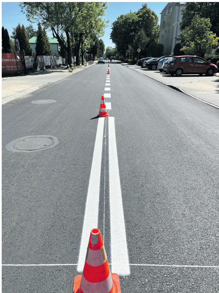
Remont ulicy Laskowej w Grójcu
