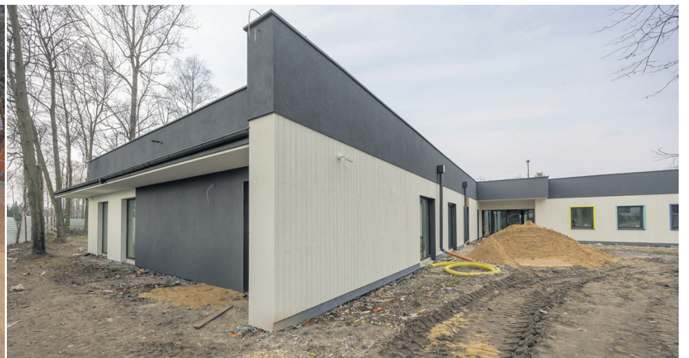
Budowa żłobka samorządowego w Grójcu
