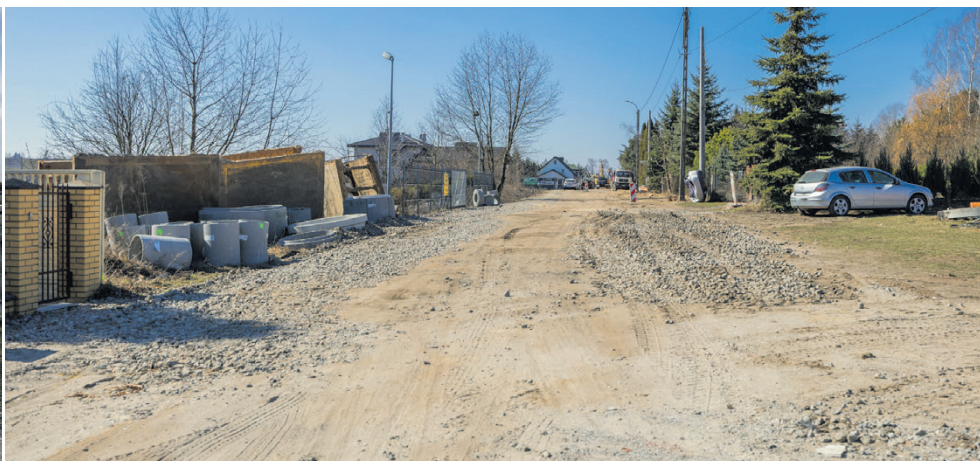
Ulica Francuska w Grójcu – w trakcie budowy
