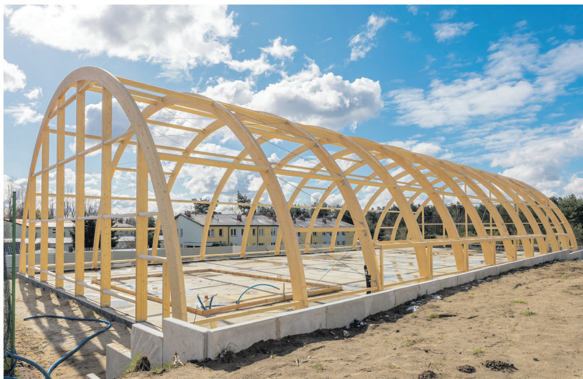
Budowa zadaszonego boiska w Częstoniewie
