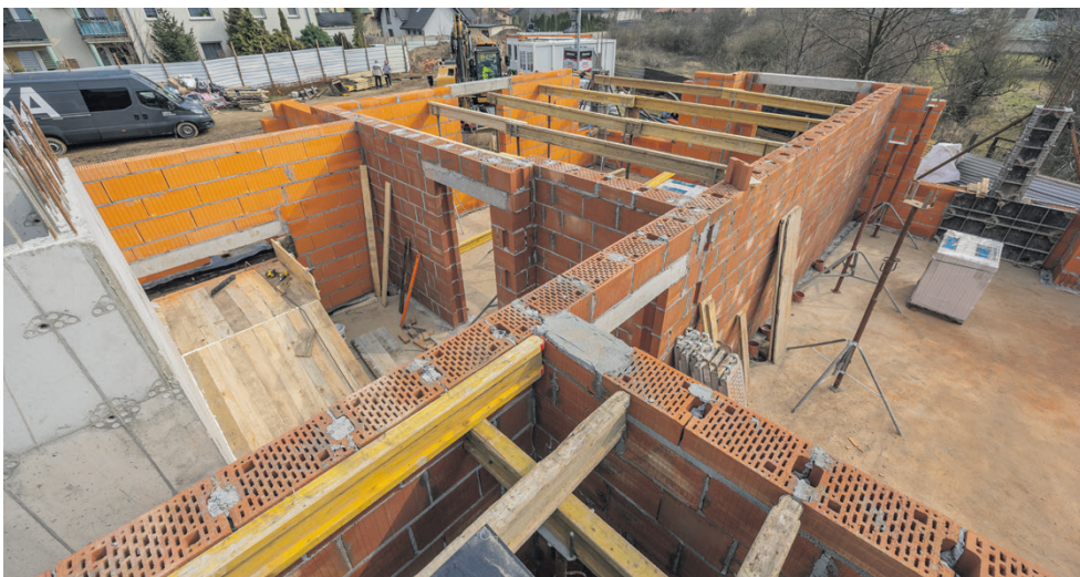
Budowa budynku komunalnego przy ul. Jana Pawła II w Grójcu
