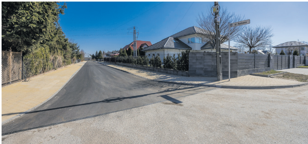
Ulica Wesoła w Grójcu – po przebudowie
