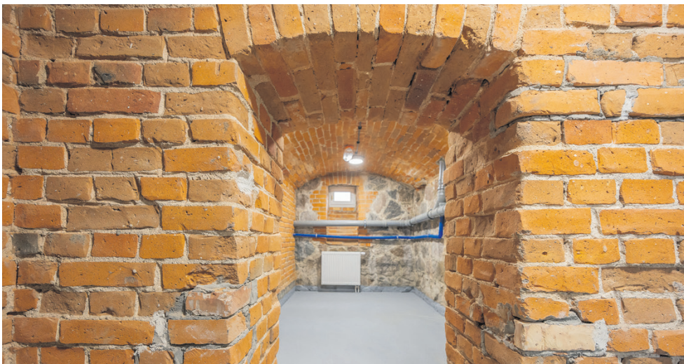
Rewitalizacja budynku dworca kolejki wąskotorowej w Grójcu – wnętrze
