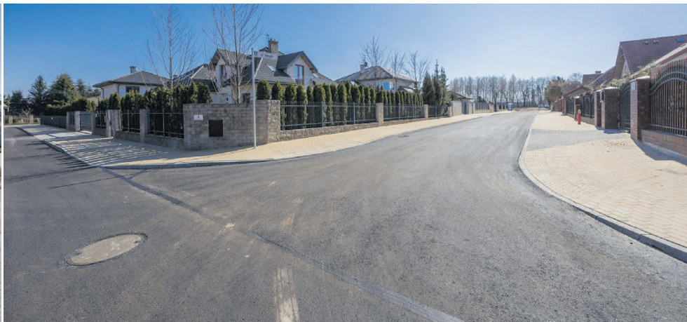
Ulica Wesoła w Grójcu – po przebudowie
