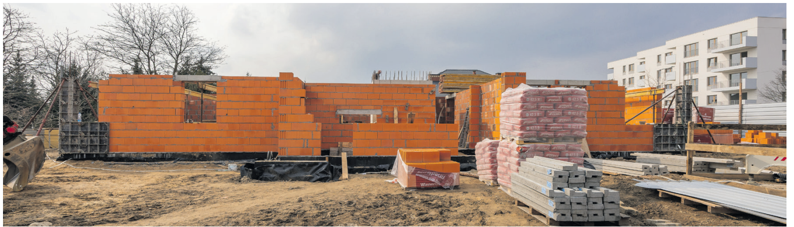
Budowa budynku komunalnego przy ul. Jana Pawła II w Grójcu
