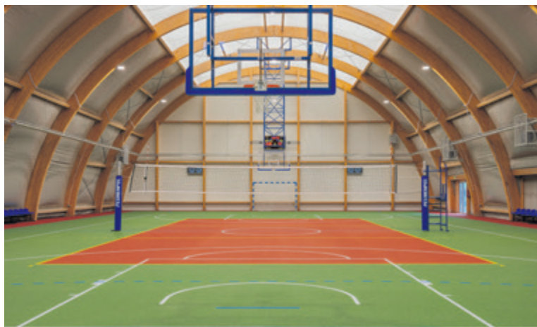
Budowa wielofunkcyjnego zadaszonego boiska przy PSP w Częstoniewie
