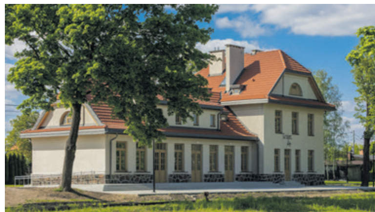
Rewitalizacja dawnego dworca kolejki wąskotorowej w Grójcu
