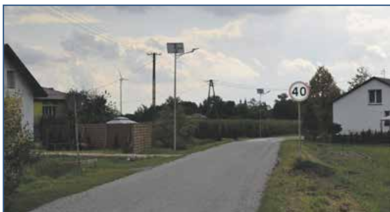
Montaż lamp solarnych - sołectwo Pełowo
