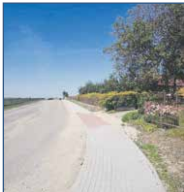
Kontynuacja budowy chodnika w sołectwie Łętowo
