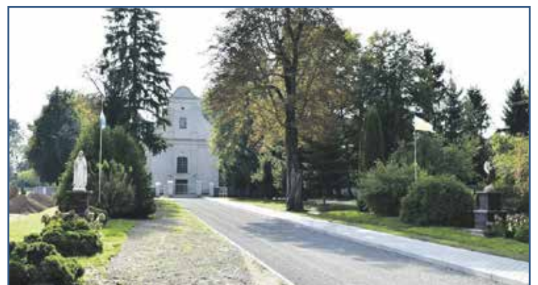
Przebudowa drogi gminnej w sołectwie Kępa Polska
