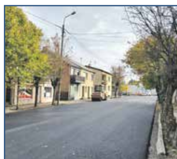
Remont nawierzchni ulicy Kilińskiego w Bodzanowie
