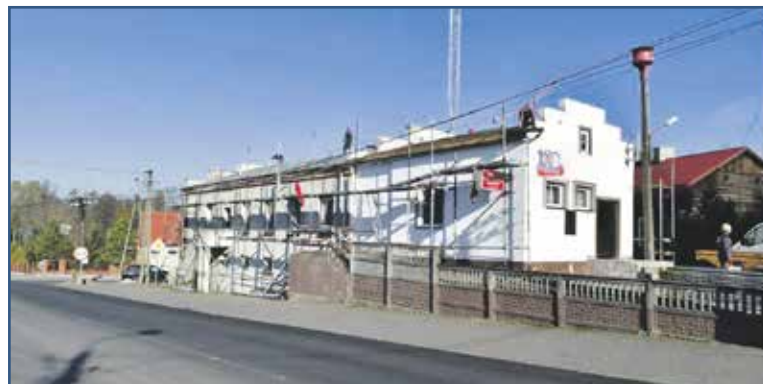
Modernizacja budynku OSP w Bodzanowie
