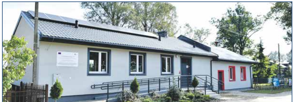
Świetlica wiejska w Kępie Polskiej
