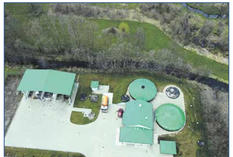
Oczyszczalnia ścieków w Bodzanowie
