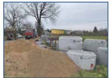
Budowa kanalizacji sanitarnej na odcinku Chodkowo-Karwowo Duchowne
