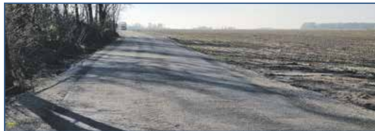
Przebudowa nawierzchni drogi gminnej w sołectwie Gromice
