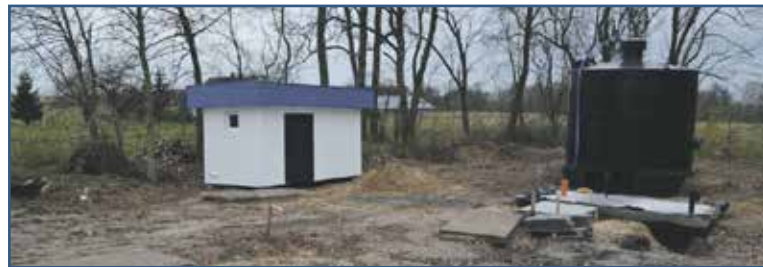
Budowa pompowni pośredniej w Nowym Kanigowie
