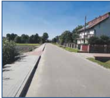
Budowa chodnika przy drodze gminnej w m. Kłaczku
