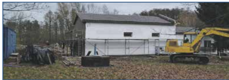
Modernizacja Stacji Uzdatniania Wody w Leksynie
