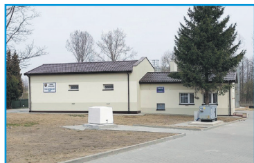
Zmodernizowana Stacja Uzdatniania Wody w Leksynie
