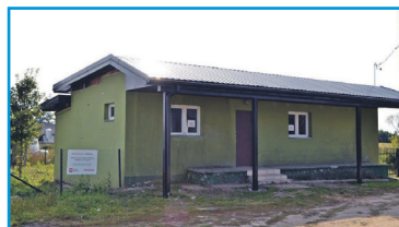
Przebudowana świetlica wiejska w Cybulinie
