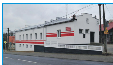
Termomodernizacja budynku OSP w Bodzanowie
