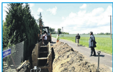
Kanalizacja sanitarna Nowe Miszewo-Borowice
