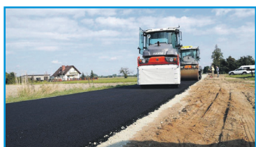
Odbudowa drogi Nowe Miszewo-Borowice
