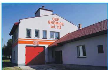
Termomodernizacja budynku OSP w Gromicach
