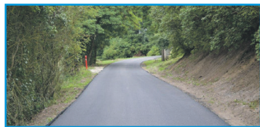
Wodociąg i droga w Gromicach
