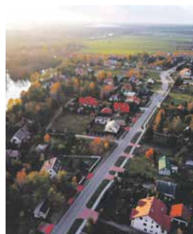
Budowa drogi gminnej relacji Wykowo-Białobrzegi
