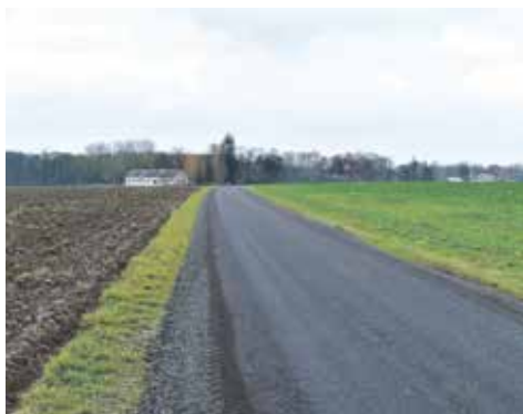
Droga w Gromicach 2018 r. - 2019 r.
