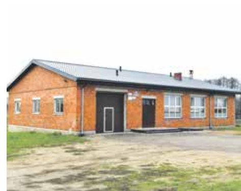
Przebudowa świetlicy wiejskiej w Nowym Kanigowie, 2018 r.
