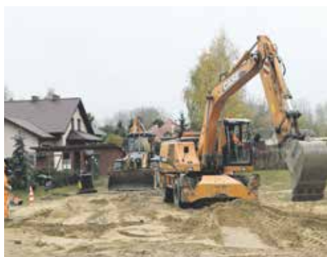
Kanalizacja deszczowa w Białobrzegach, 2019 r.
