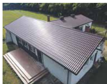
Przebudowa świetlicy wiejskiej w m. Borowice
