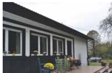
Przebudowa świetlicy wiejskiej w m. Borowice
