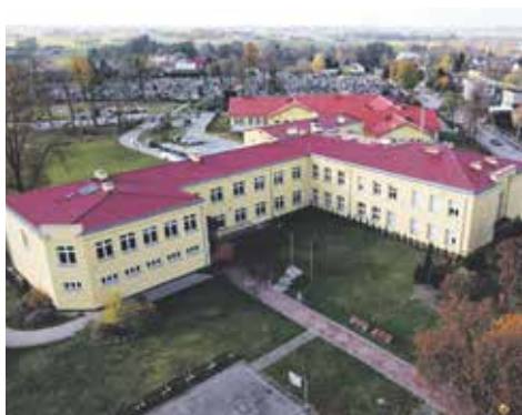
Termomodernizacja ZPO w Bodzanowie, 2018 r. wartość inwestycji ponad 1,6 mln zł
