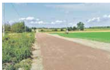
Przebudowa drogi gminnej w Łagiewnikach etap I
