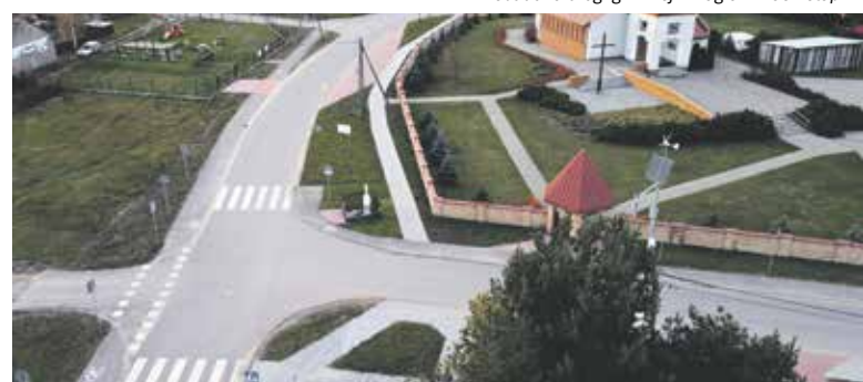
Budowa i przebudowa ul. Długiej w Białobrzegach
