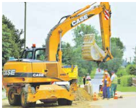
Kanalizacja sanitarna w aglomeracji Bodzanów, 2016 r. - 2019 r. długość wybudowanej sieci 15 km
