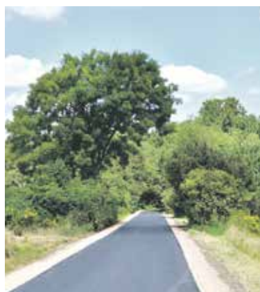
Przebudowa ul. Dojazdowej w Białobrzegach
