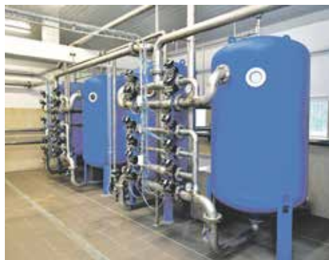
Rozbudowa Stacji Uzdatniania Wody w Reczynie 2020 r., wartość inwestycji ponad 1,3 mln zł
