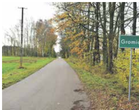
Droga w Gromicach, 2018 r. - 2019 r.
