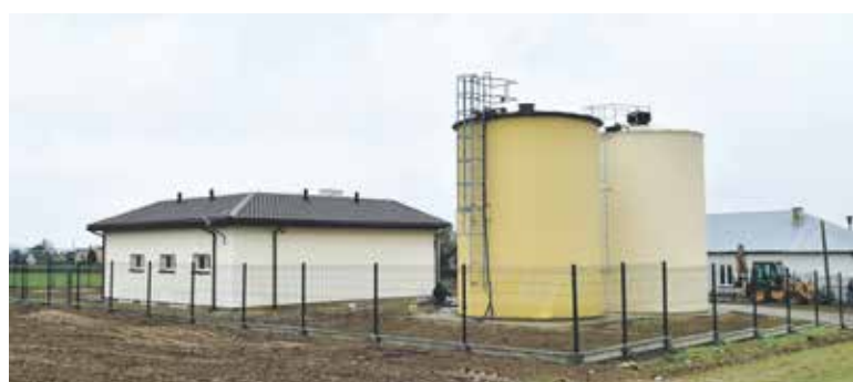
Rozbudowa Stacji Uzdatniania Wody w Reczynie
