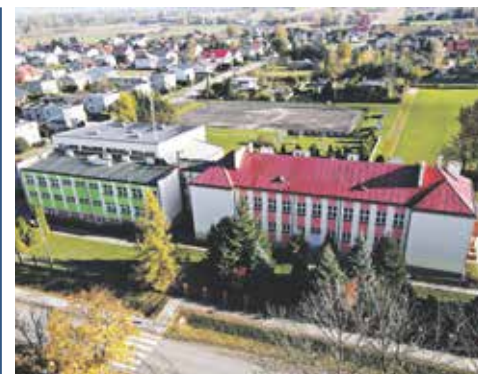
Termomodernizacja ZPO w Nowym Miszewie, 2015 r.
