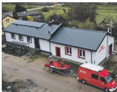
Świetlica wiejska i magazyn przeciwpowodziowy w budynku OSP Kępa Polska, 2019 r. - 2020 r.
