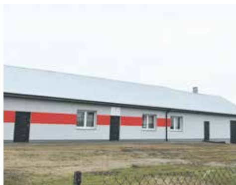
Świetlica wiejska w Wiciejewie, 2019 r. - 2020 r.
